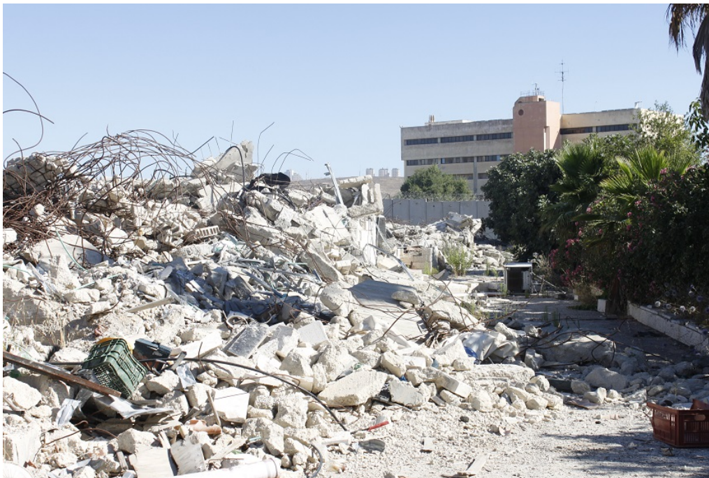
Casas palestinas destruidas en Qalandia con el muro al fondo. / Foto: M a Ángeles Fernández
