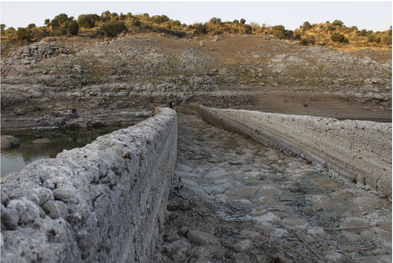
Interior del puente / MAF
