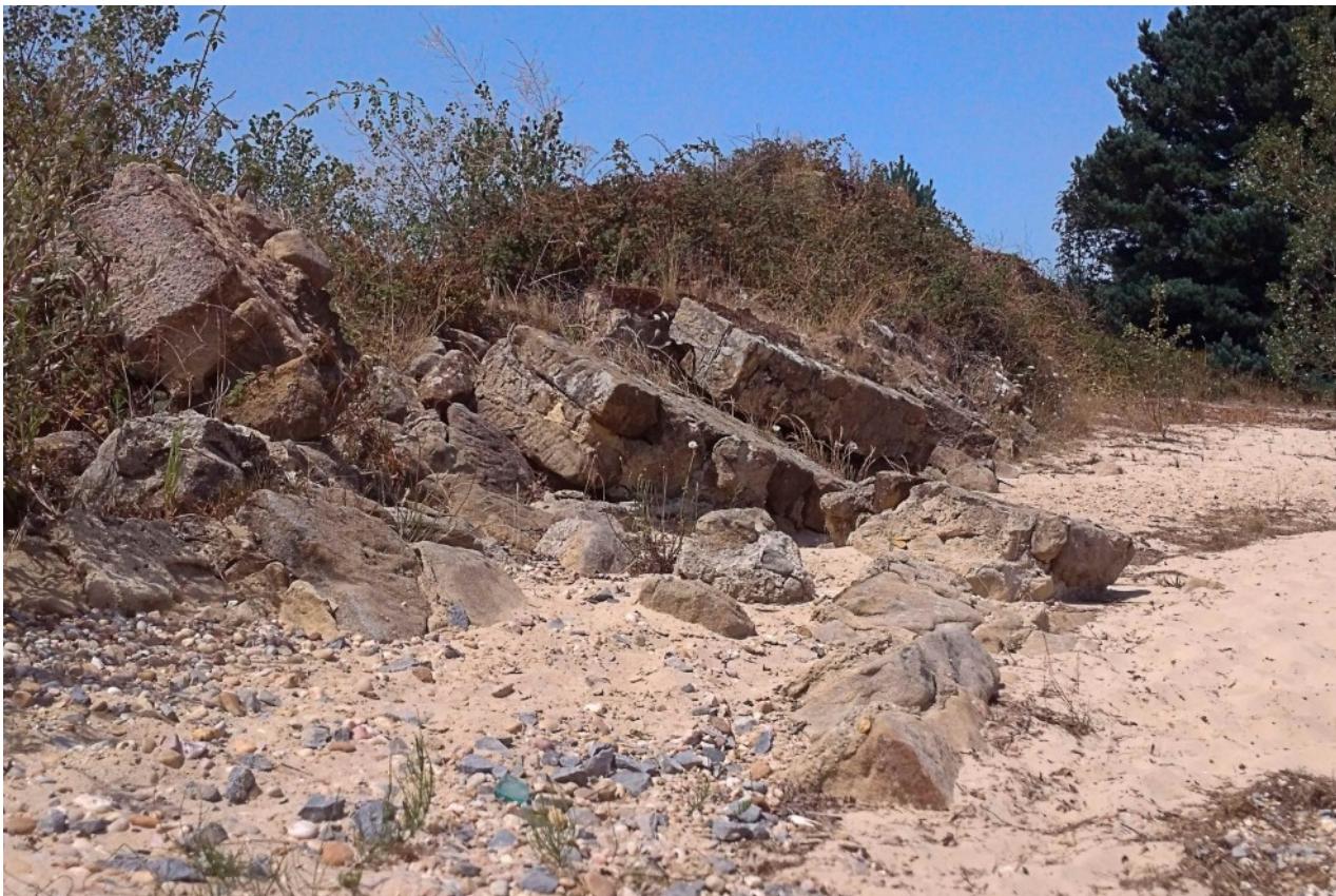
Estado actual en el que se encuentra el puente Noguero. — M.A.F.
