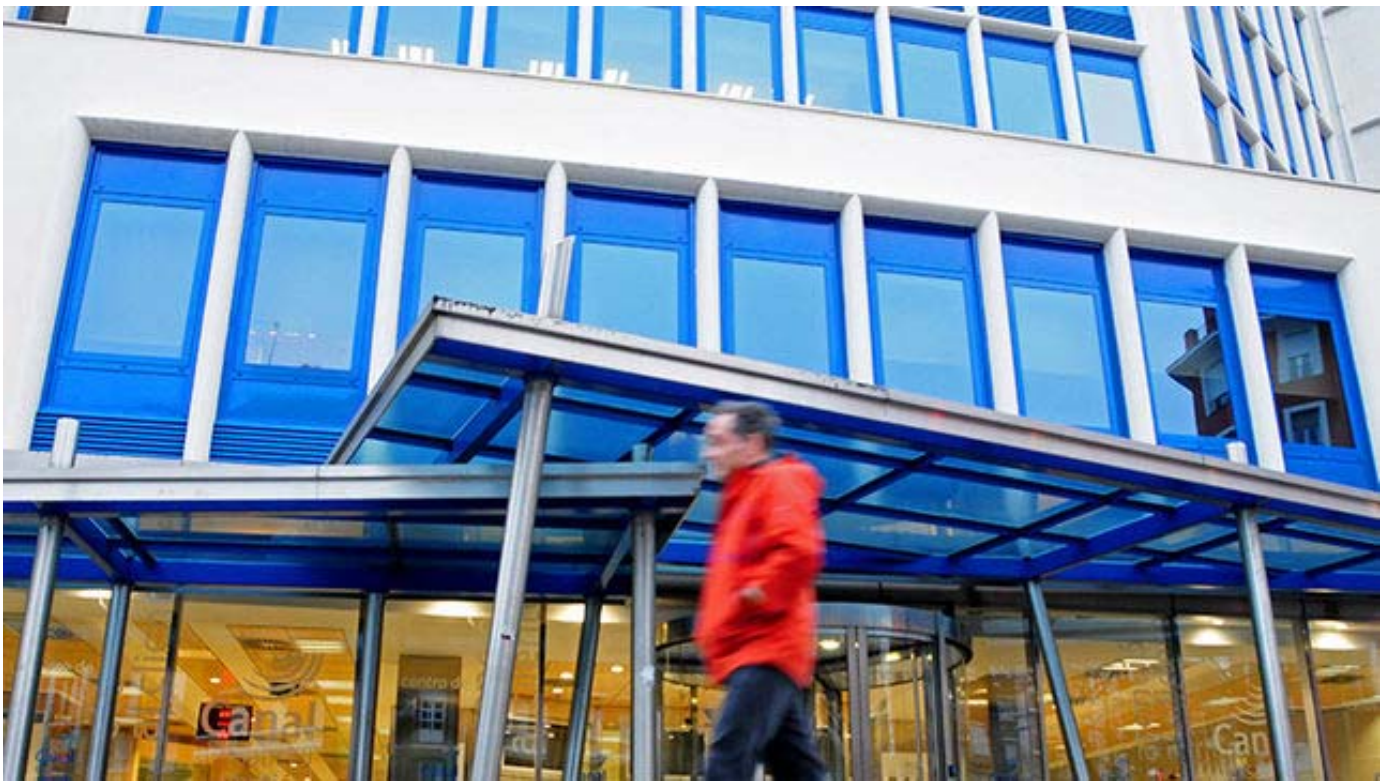
Edificio del Canal de Isabel II
