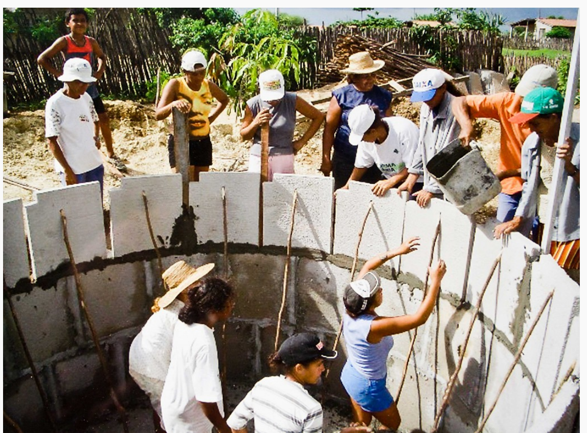
Un grupo de mujeres participan en la construcción de un tanque de almacenamiento de agua de lluvia en Brasil/ FAME
